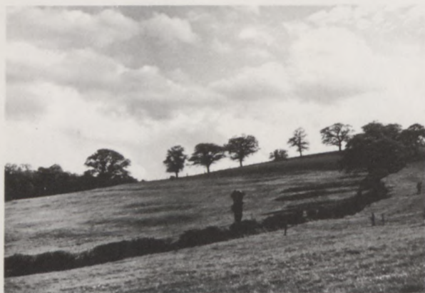
Fig. 4 Sewardstone No. 6. 10½ degree slope, old slip Talus à 10½ degrés, ancien glissement
